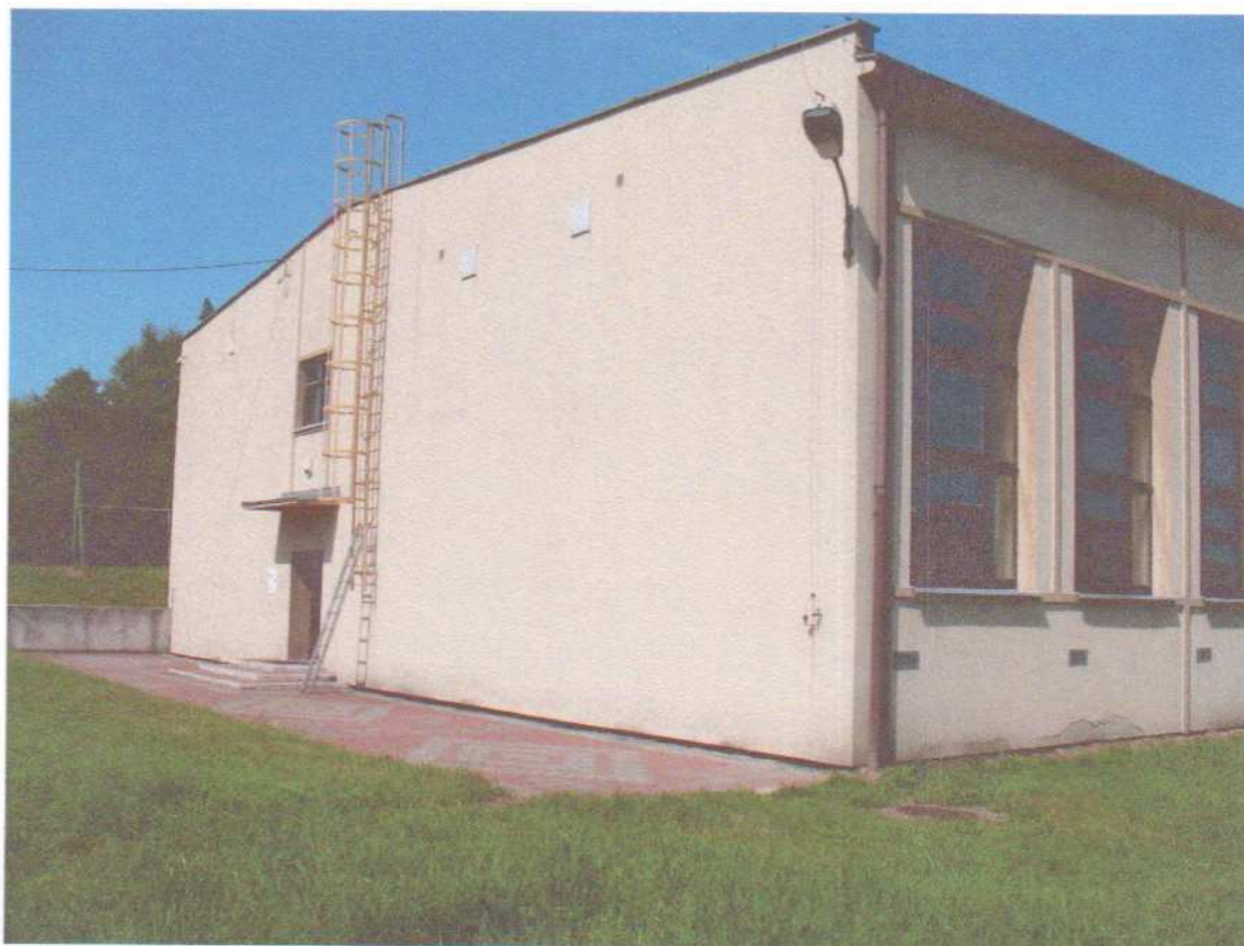
Fot. 2 Elewacja południowa
