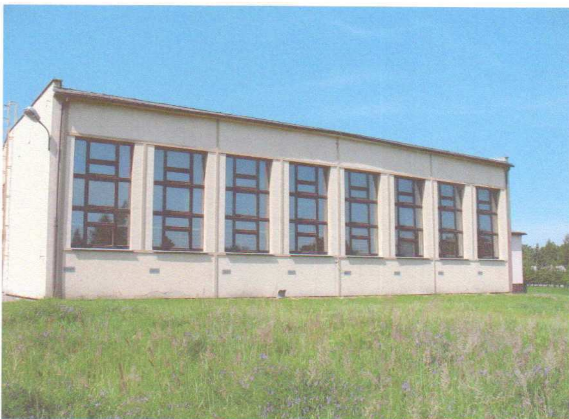
Fot. 1 Elewacja wschodnia
