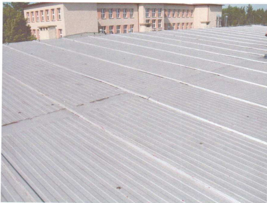
Fot. 3 Widok istniejącego poszycia dachu
