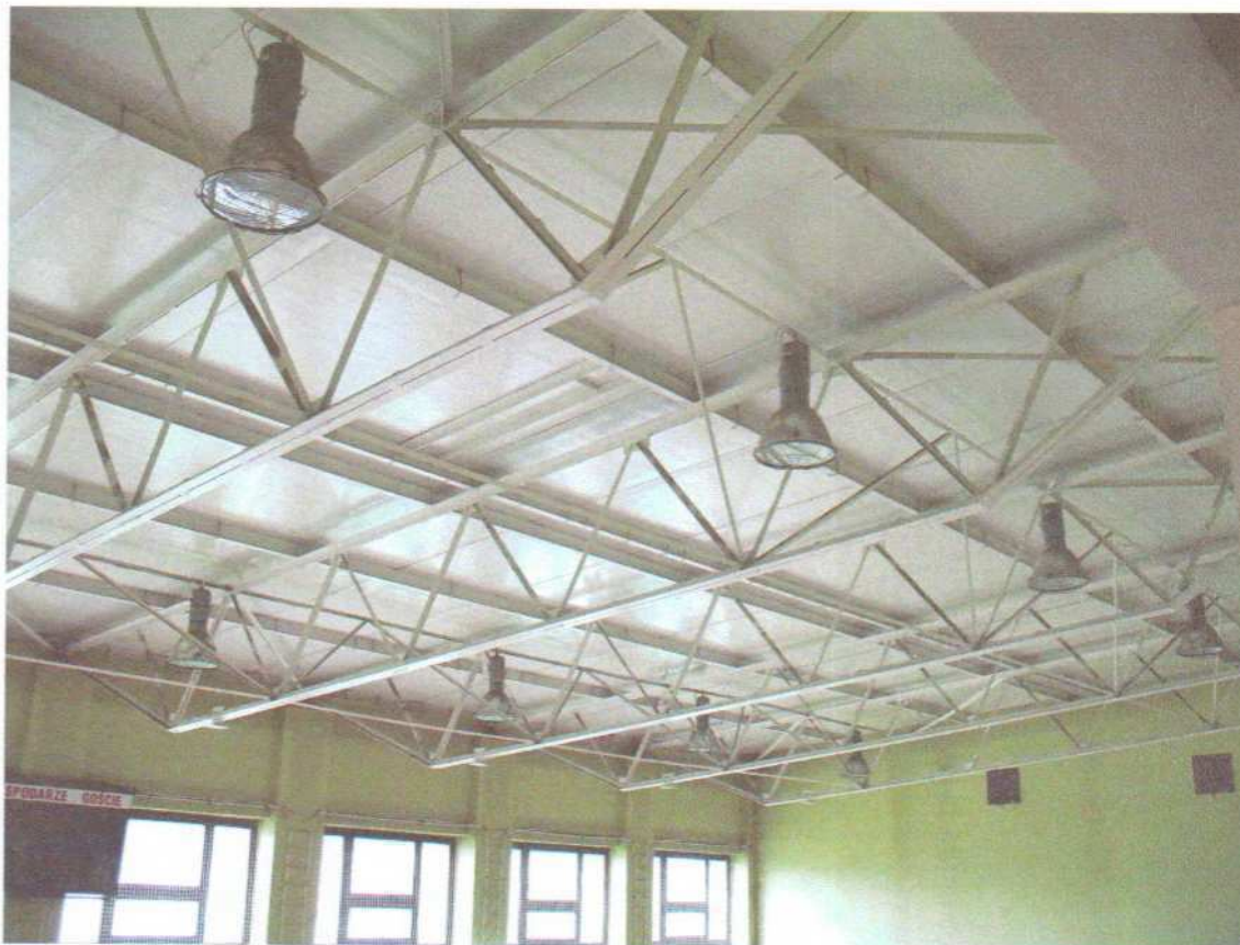
Fot. 3 Istniejąca konstrukcja nośna dachu
